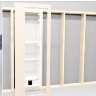
5. Montering av plater
