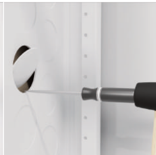
3. Utblokking til rør
