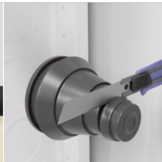
4. Montering av muffer
